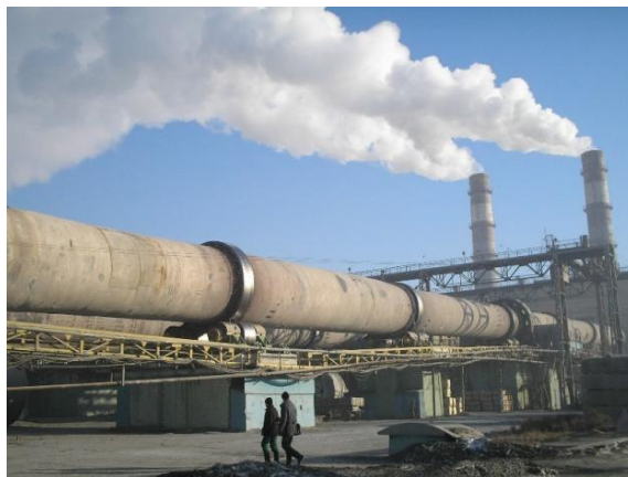
Фото 16. Трубы Цементного завода в г. Фокино( Портланд цемент)
